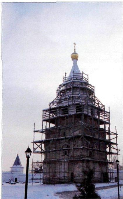
Колокольня Лужецкого монастыря стоит сейчас в лесах.
